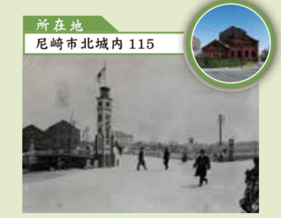
所在地 尼崎市北城内 115 庄下橋(左後方に倉庫)1937(昭和12)年か ★
