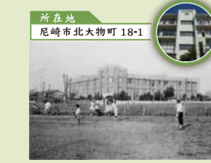
所在地 尼崎市北大物町 18-1 縣立尼ヶ崎中学校 1933(昭和8)～37(昭和12)年 ★
